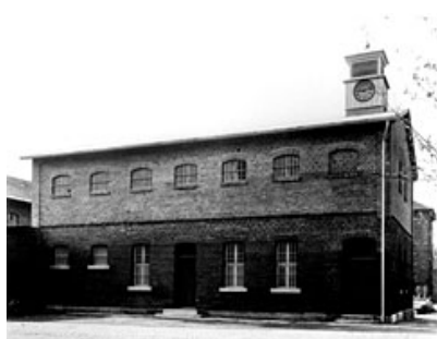
Le bâtiment d'exécution et son clocher, autour de 1943
